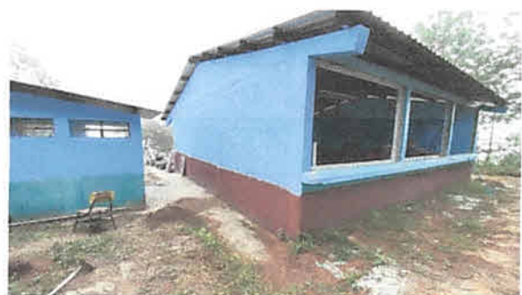
Foto 6: Resanado de ventanales.
