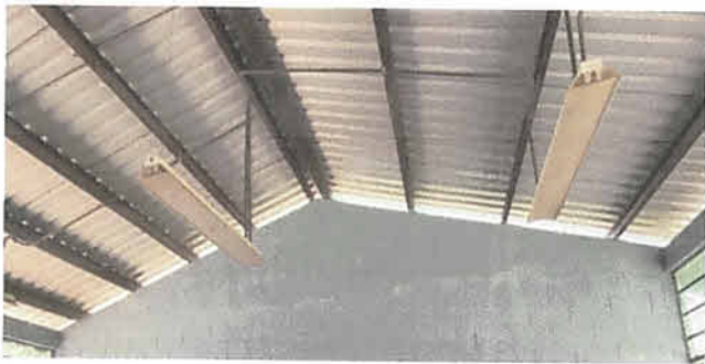
Foto 5: Resanado de techo.
